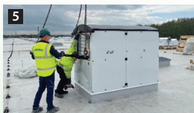
5 Plaatsing van de unit op de dakopstand
