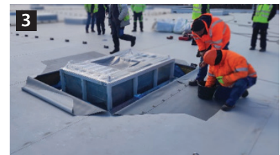
3 Montage geluiddemper in dak opstand
