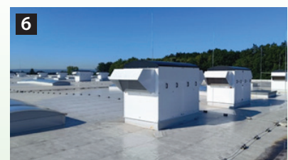
6 Kappen tegen inregenen. Tot slot: montage van het kanaalwerk vanaf de onderkant.
