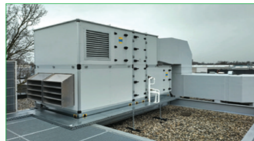
Ecovent RO opstelling met een luchtverplaatsing van 10.000 m 3 /h, gerealiseerd in Eindhoven
