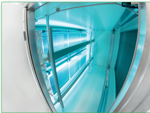
Filtering door middel van UV-C lampen
