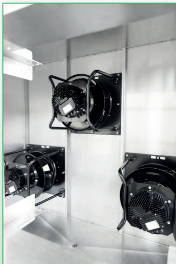
EC-ventilatoren zorgen voor een minimale energie verbruik
